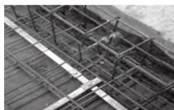
Als Potentialausgleich wird in der Fundamentierung/Bodenplatte gebäu-deumlaufend ein verzinkter **Fundamenterder** mit einer Anschlussfahne aus **Edelstahl** im Hausanschlussraum eingebaut. Diese wird später durch den Elektriker in die Elektroinstallation eingebunden und ange-schlossen. Er dient als Erdungsanschluss für die Elektroinstallation. Zu-sätzlich wird ein Ringerder aus Edelstahl verlegt.
