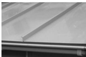
Die Eindeckung des Satteldachs erfolgt mit **Zink-Stehfalz vorbewittert**. Die Unterkonstruktion besteht aus einer kompletten Verschalung der Dachsparren aus **Holzfaserdämmung** gemäß Energiepass, mit aufliegender Lattung. First, Ortgang und Traufe werden passend aus Kantteilen hergestellt. Erforderliche Lüftungsrohre werden angefertigt und in die Eindeckung eingebaut.
